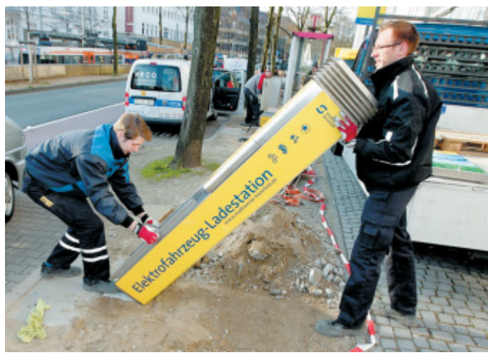
An der neuen Säule: Fabian Beinlich (links) und Sergej Lange installieren eine der zwei neuen Säulen am Niederwall. FOTO: WOLFGANG RUDOLF
